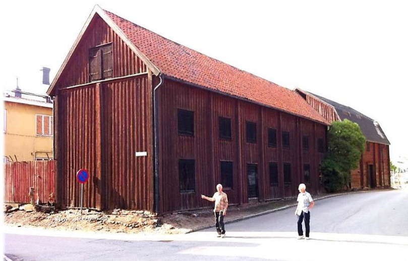
Stadens enda kvarvarande magasin från tiden kort efter grundandet. Magasinen ligger vid Arvid Nilssonsgatan, mot hamnen nedom korsningen med Spårgatan, se karta ovan. De finns kvar ännu sommaren 2013 men hotas av rivning, något som vållar intensiv debatt i Karlskrona. Foto vid besök med bröderna 2013
